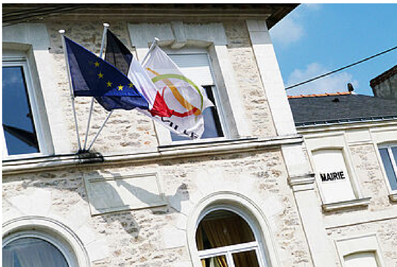
Services administratifs-La Poste-Médiathèque
