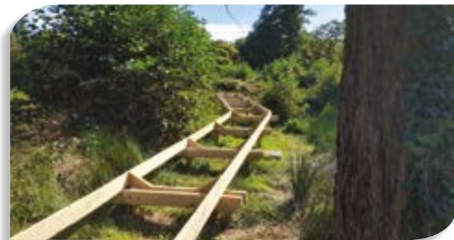
Passerelle en cours de travaux
