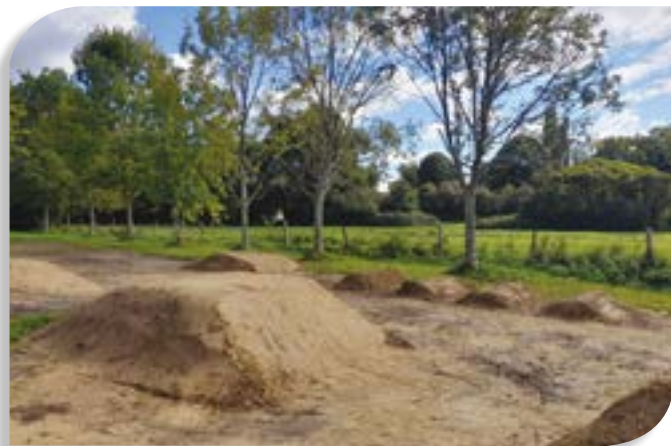
Pump Track en cours de travaux
