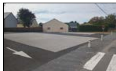
Zoom sur...les travaux en cours
