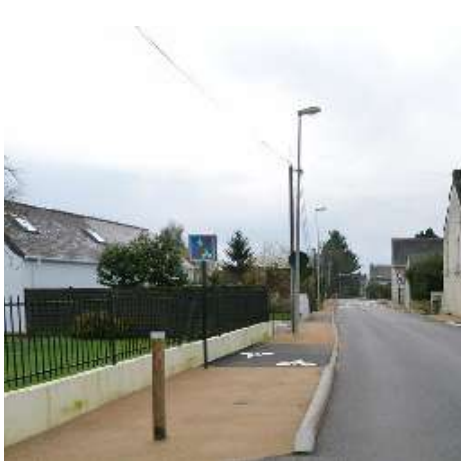
1 ère tranche des travaux
