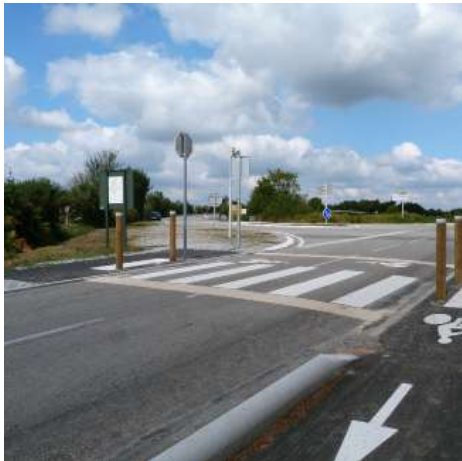
2 ème tranche, travaux finalisés
