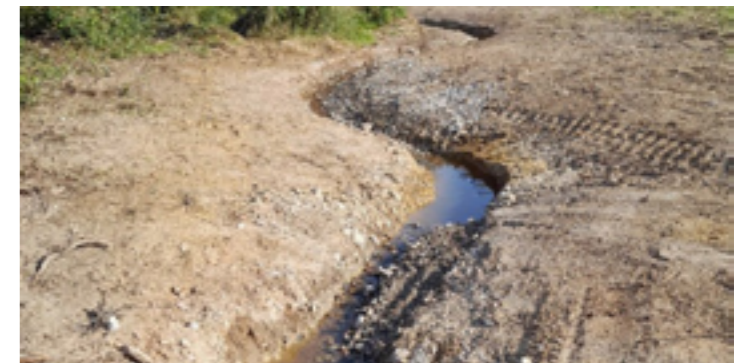
Exemple d'un cours d'eau restauré juste après travaux
