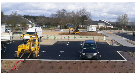
Travaux Place de la Liberté
